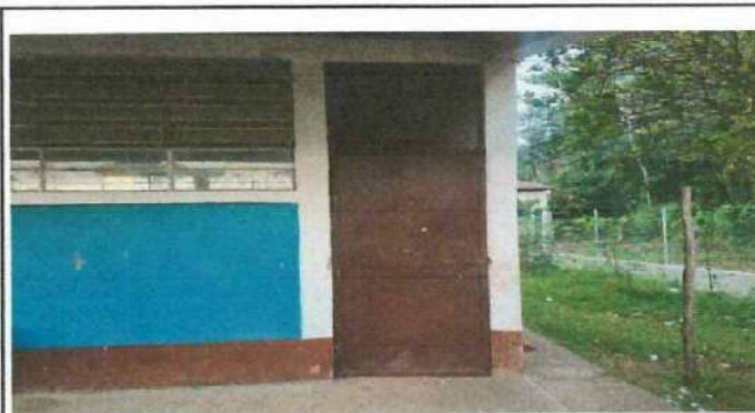
Foto 4: SUSTITUCION DE PUERTA DE METAL EN MAL ESTADO
