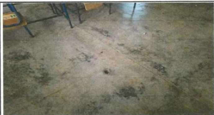
Foto 1: SUSTITUCION DE PISO LISO A PISO CERAMICO POR DETERIORO EN LAS AULAS
