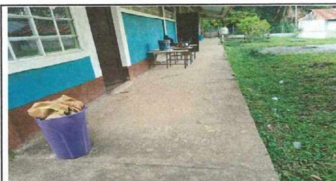
Foto 3: SUSTITUCION DE PISO DE CONCRETO
