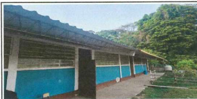
Foto 5: SUSTITUCION DE VENTAS POR BALCONES
